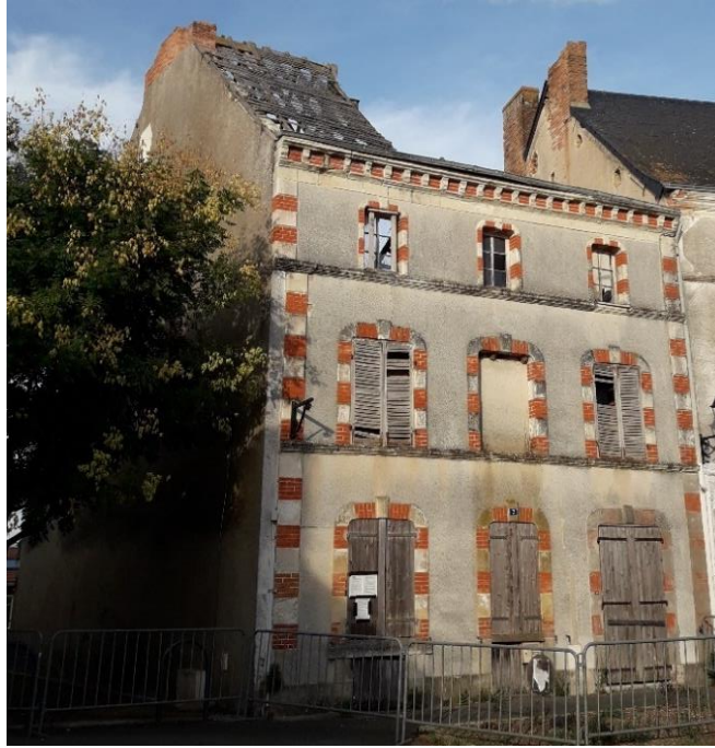
Figure 2 : Bâtiment situé au 7 place Saint Pierre, façade sud-ouest côté rue
