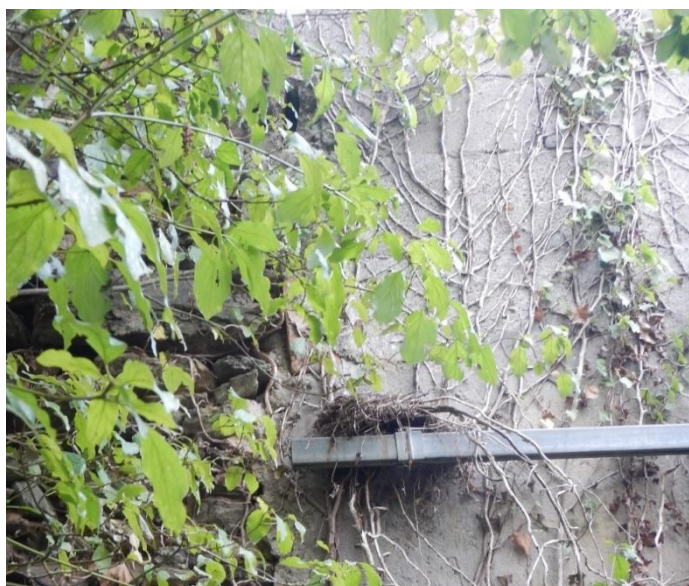
Figure 13 : Nid installé sur le rail du portail observés en 2022
