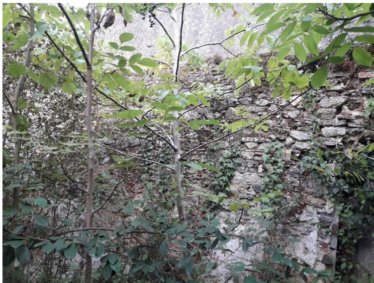
Figure 20 : Mur en pierre présentant des anfractuosités favorables aux chiroptères
